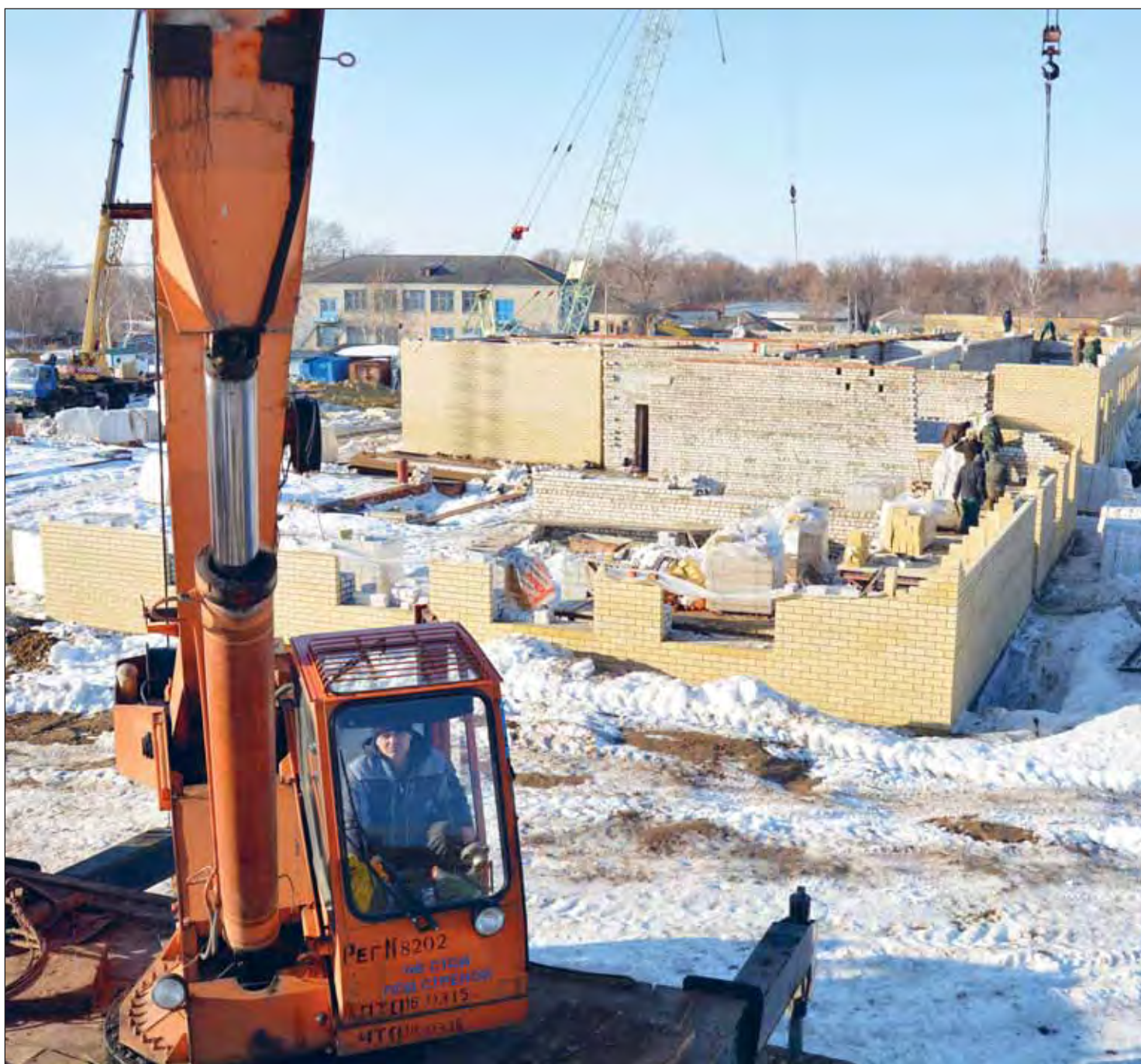
Одна из стен новой школы возведена до уровня первого этажа
